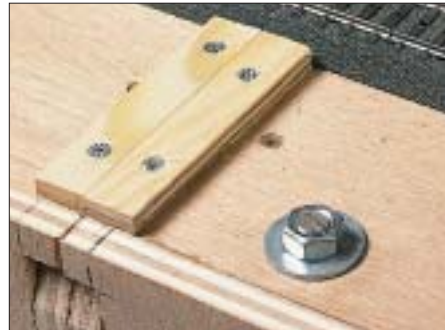
Oben und rechts: Um die Anlage zum Kunden transportieren zu können, wurde sie in etliche Segmente aufgeteilt. Dank zahlreicher Gewindestangen kann sie an ihrem späteren Standort exakt justiert werden.
